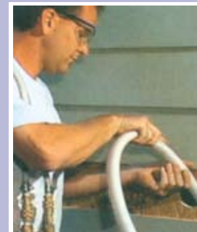
Existing Stud Walls
